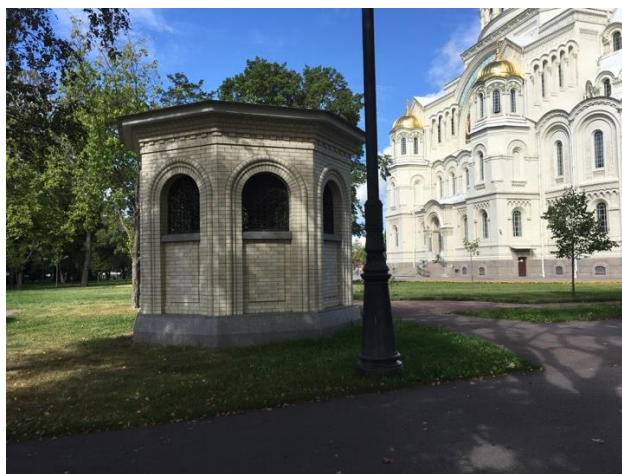
Рис. 11. Воздухозаборные киоски, расположенные в парковой зоне при Морском Соборе во имя Святителя Николая Чудотворца в Кронштадте
