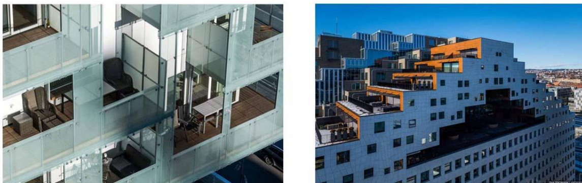
Рис. 8. Осло Barcode (Штрихкод). Большие открытые балконы и террасы, снабженные общедомовой системой водоотведения
