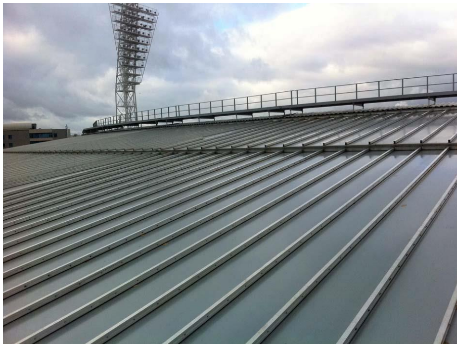
Рис. 7. Модульные полимерные панели в составе большепролетного светопрозрачного покрытия (фото автора)
