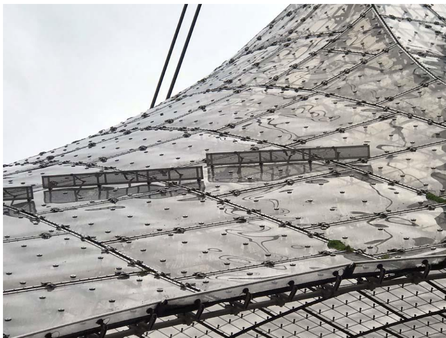
Рис. 5. Монолитные полимерные панели в составе большепролетного светопрозрачного покрытия (фото автора)
