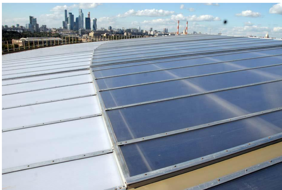
Рис. 6. Многослойные полимерные панели в составе большепролетного светопрозрачного покрытия (фото автора)
