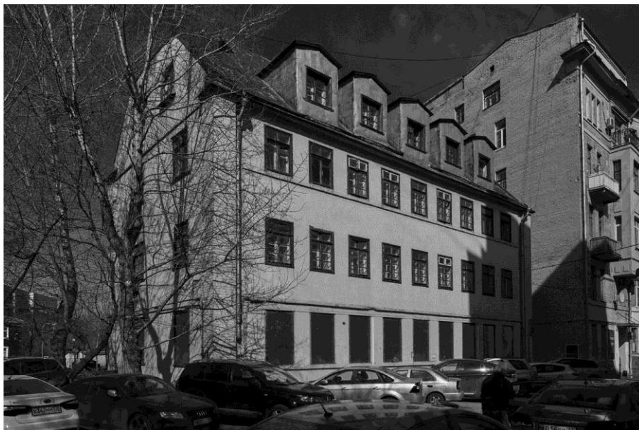
Рис. 2. Жилой дом кооператива «Трудкоопстрой». Арх. В. Циммер, 1929 г. 6-й Ростовский пер, д. 4а
