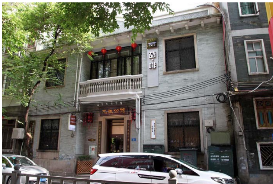
Рис. 4. Дау, ул. Баюань 81, г. Гуанчжоу (фото автора)
