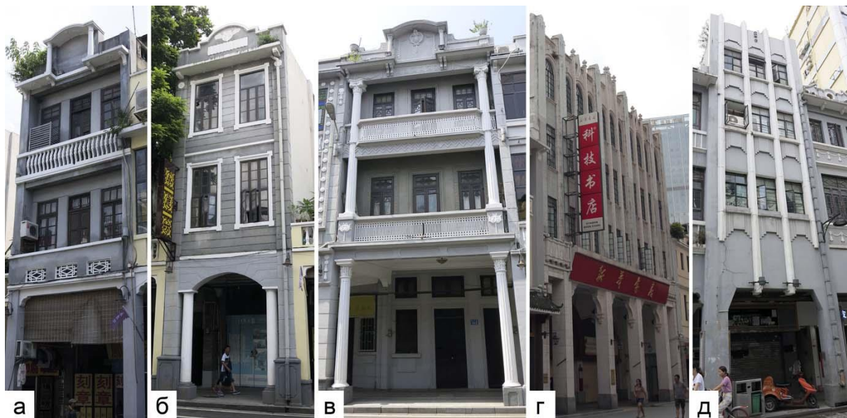
Рис. 6. Стилизация европейской архитектуры (фото автора): а) ул. Эньнин, 89; б) ул. Эньнин, 85; в) ул. Эньнин, 140; г) магазин «Синьхуа» на ул. Бэйцзин; д) ул. Шанцзю, 92
