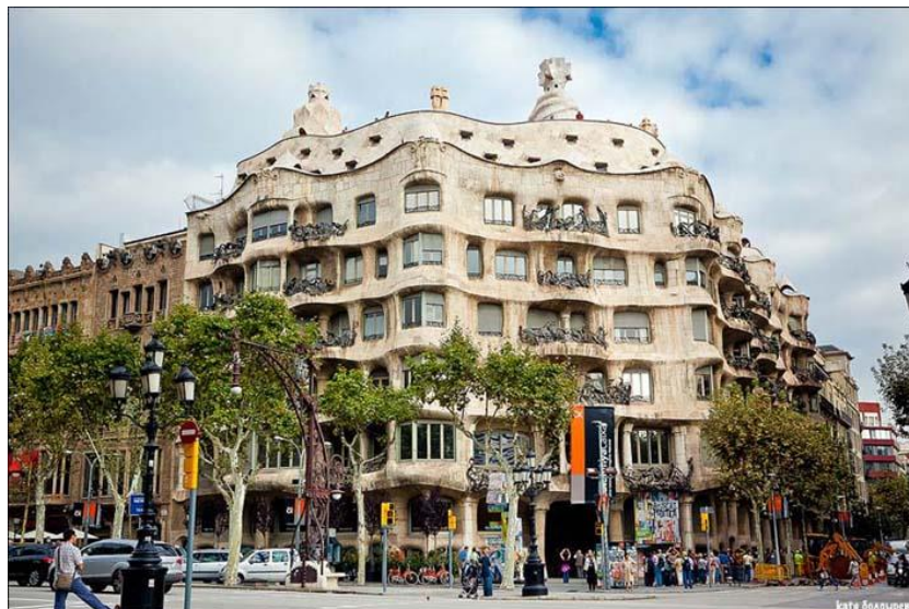
Рис. 6. Дом Мила, Испания, Барселона, 1906 г., арх. Антонио Гауди
