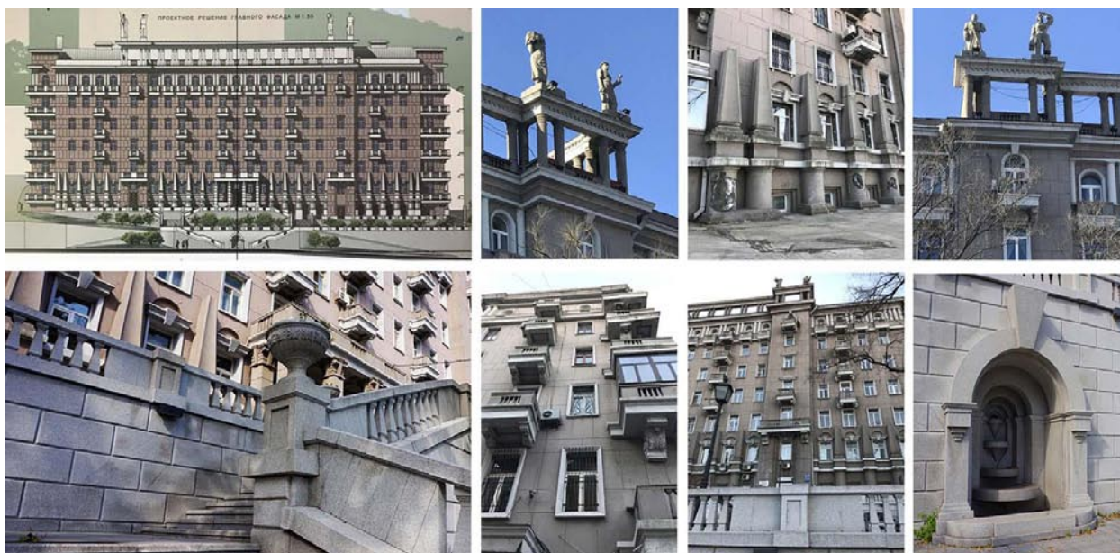
Рис. 6. Дом на улице Алеутской № 17, разработан архитекторами А.И. Порецковым и Н.А. Бигачевым
