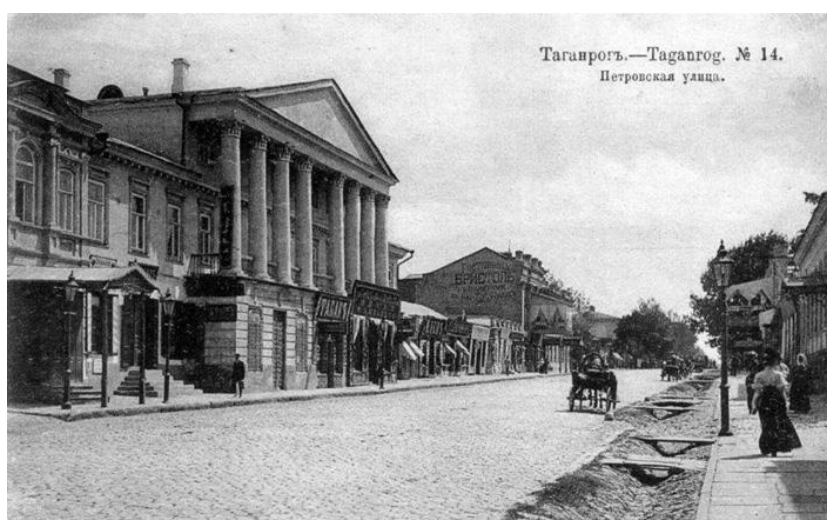
Рис. 4. Улица Петровская г. Таганрог, отводящая канава в профиле улицы
