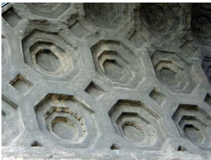
Рис. 7. Кессоны бетонного купола Пантеона, Рим, Италия
