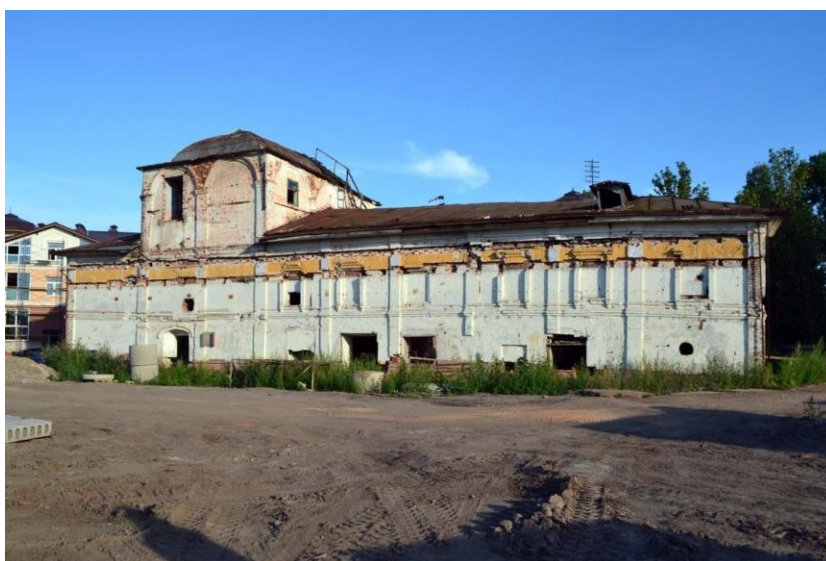
Рис. 3. Северный фасад церкви Богоявления. Современное состояние
