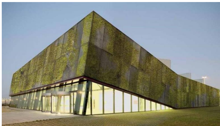
Рис. 3. Фасады здания из биобетона ( URL:http://remvideo.ru/images )
