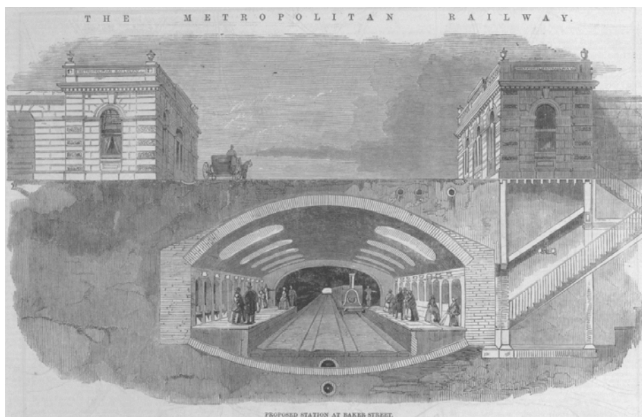
Рис. 6. Станция Бейкер-Стрит линий Хаммерсмит-энд-Сити и Кольцевой, открыта в 1863 г., старейшая действующая станция Лондонского метро. Вентиляционные каналы станции «Бейкер стрит», позже были заложены, а в 1980-е переоборудованы в световые ниши
