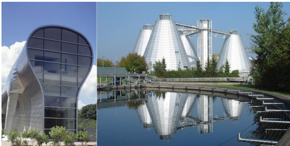
Рис. 9. Станция по очистке сточных вод в городе Гамден, арх. С. Холл, 2005 г., США (слева); завод по сжиганию и переработке осадков сточных вод в Мюнхене, арх. бюро Askermann Architekten BDA, 1988 г., Германия (справа)
