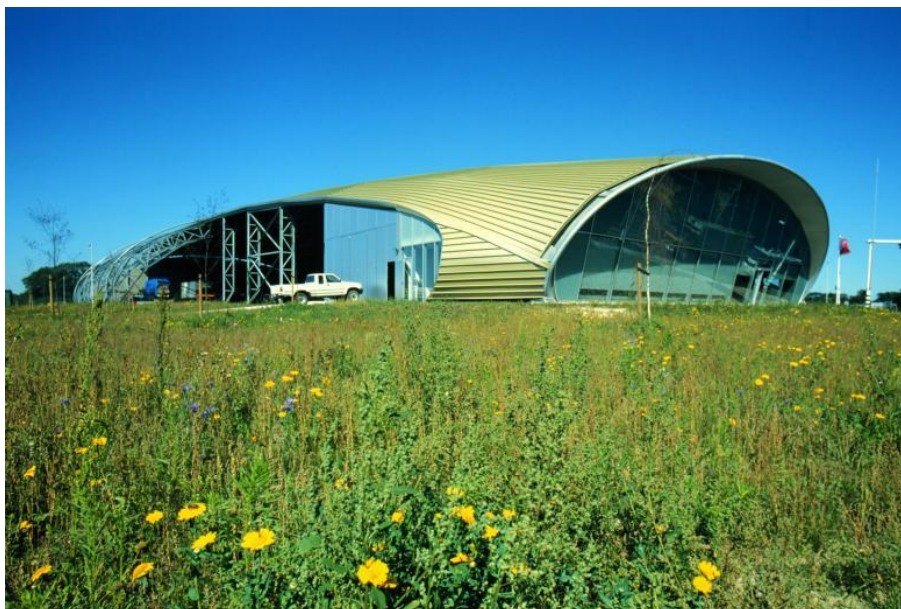
Рис. 3. Мусороперерабатывающая станция в городе Зендерен, арх. Kas Oosterhuis, 1995 г., Нидерланды
