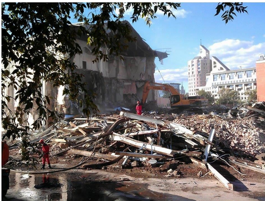
Рис. 1. Снос суконной фабрики Бахрушиных в Кожевническом проезде вл.4 с. 3 (архив общественной организации «АрхНадзор» – дата съёмки 14 августа 2015 г.)
