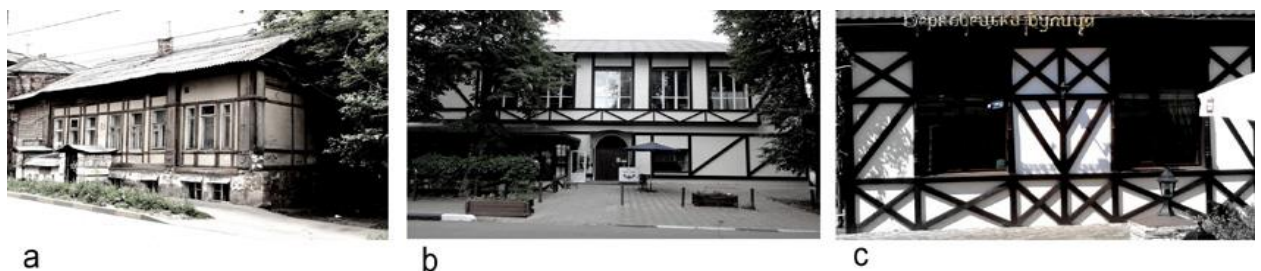
Рис. 3. Классификация фахверковых строений в отношении формы сочленений элементов каркаса: а) монофахверк – здание в Нижнем Новгороде; б) мезофахверк – здание в Долгопрудном; в) полифахверк – кафе в Киеве
