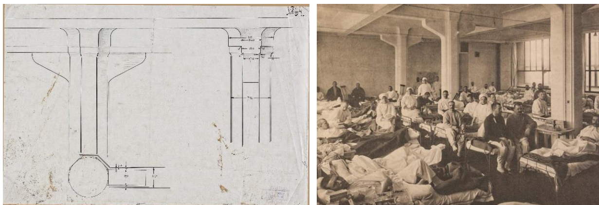
Рис. 1(а,б): а) чертеж колонны безригельного каркаса (из архива музея МАРХИ, публикуется впервые); б) фото госпитальной палаты в помещении Строгановского Императорского училища с тем же каркасом, 1915 год
