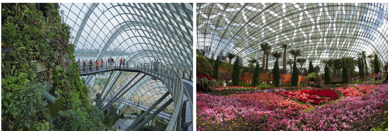
Рис. 6. Комплекс оранжерей в Сингапуре, Wilkinson Eyre Architects, 2012 год
