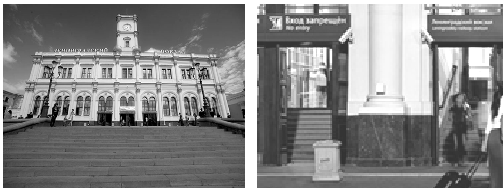
Рис. 4. Вход в здание Ленинградского вокзала после двухлетнего комплексного капитального ремонта
