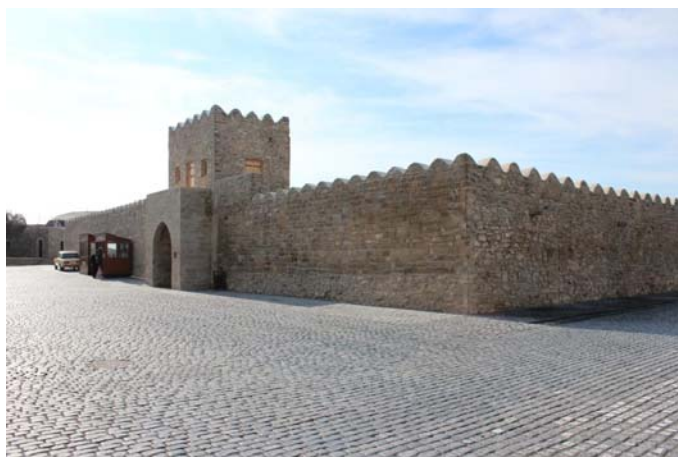
Рис. 10. Общий вид памятника после реставрационных работ. Вход на территорию комплекса
