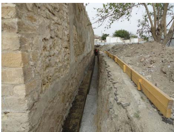
Рис. 7. Проведение работ по укреплению и изоляции фундамента
