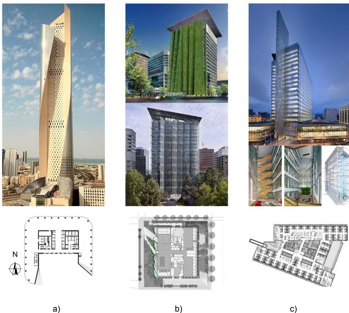
Рис. 3(а-с): а) Al Hamra Firdous Tower, Кувейт, арх. SOM (проникновению тепла в здание с южной стороны препятствует бетонная стена); б) Portland Federal Building, Портленд, штат Орегон, США (арх. SERA Architects. Вертикальное озеленение фасада - "природная" солнцезащитная конструкция); с) Manitoba Hydro Place, Виннипег, Манитоба, Канада (арх. Kuwabara Payne McKenna Blumberg Architects, Smith Carter Architects)
