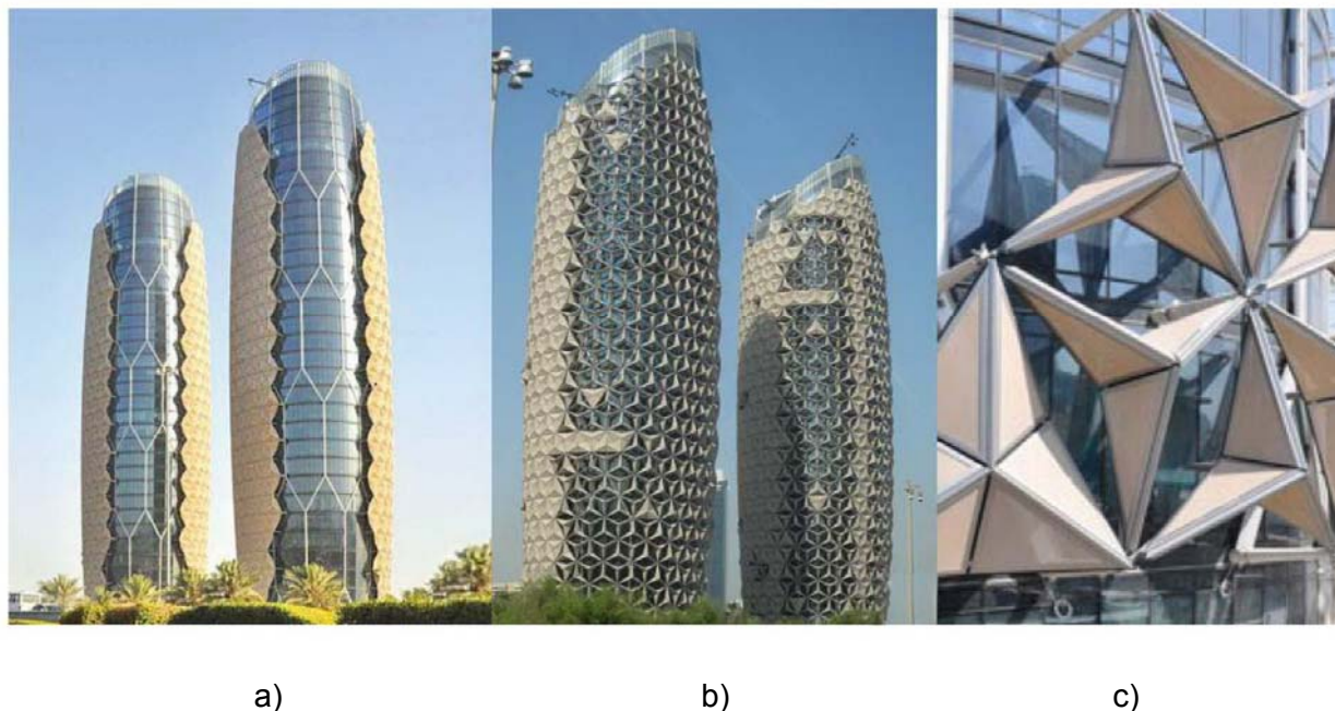
Рис. 7(а-с). Здание Al Bahar Towers, Абу-Даби, ОАЕ (арх. Aedas Architects Ltd.): а) общий вид; б) общий вид, открытые солнцезащитные устройства; с) фрагмент системы солнцезащитных устройств
