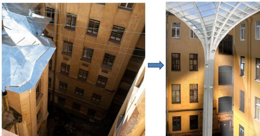
Рис. 17. Модель конструкции покрытия двора-колодца с передачей нагрузки на грунт основания и внутренним водостоком
