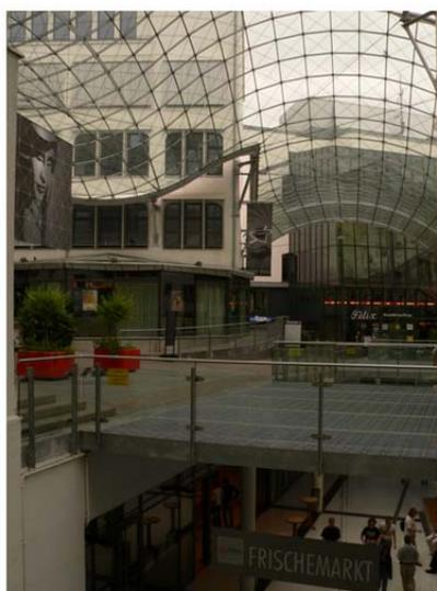
Рис. 5. Светопрозрачное покрытие пешеходных зон в г. Дармштадт, Германия
