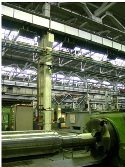
Рис. 9. УЗТМ, Екатеринбург, РФ (Инфракрасные тепловые установки в цехе)
