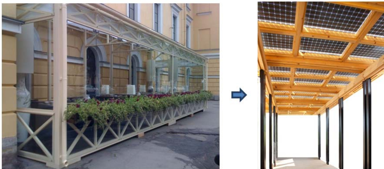
Рис. 16. Летняя терраса (традиционная конструкция и конструкция из фотоэлектрических панелей)
