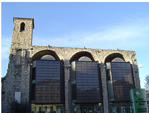
Рис. 3. Реконструированное здание Бюро по туризму (l'office du tourisme d'Ales), Франция
