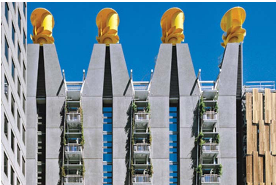
Рис. 1. Фрагмент здания Council House 2 (сертификат LEED)
