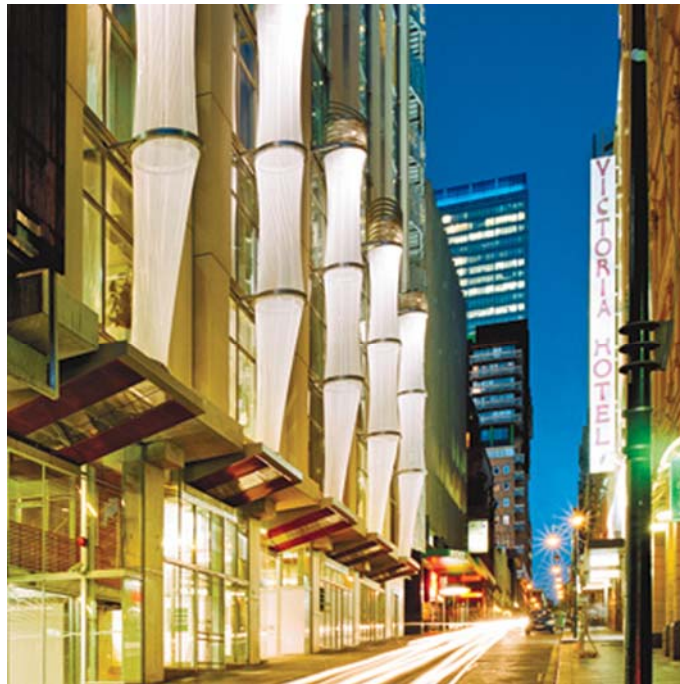
Рис. 3. Мини-градирни на южном фасаде Council House 2 (сертификат LEED)
