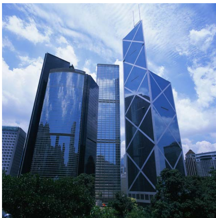
Рис. 5. Сплошные остеклённые плоскости фасадов небоскрёбов не раскрывают тектонику, а с ней и ощущение масштабности
