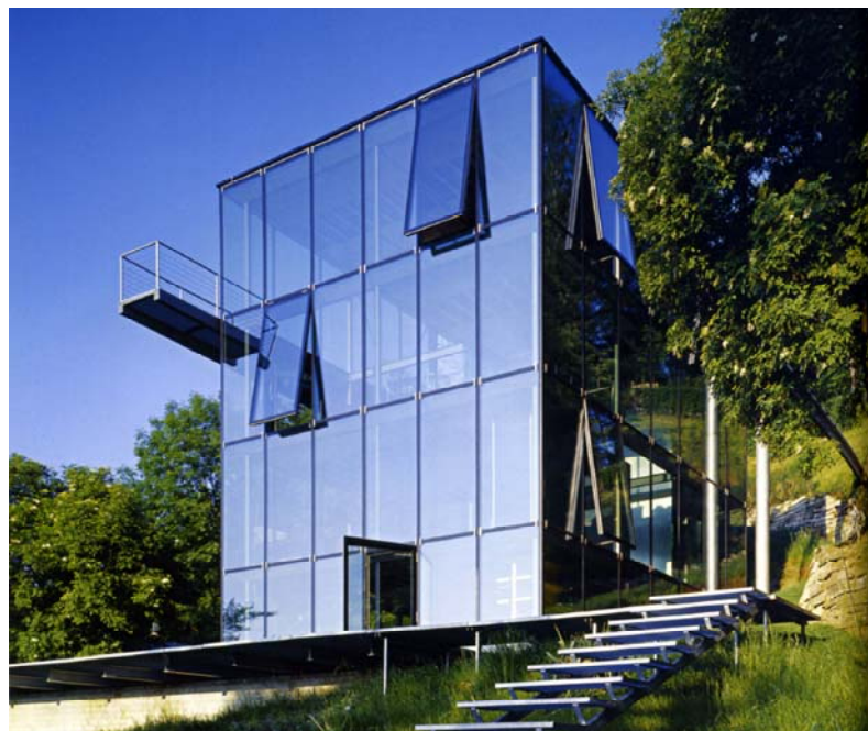
Рис. 4. Дом R-128, Штутгарт, Германия (архитектор Вернер Зобек, компания «Werner Sobek Ingenieure»)
