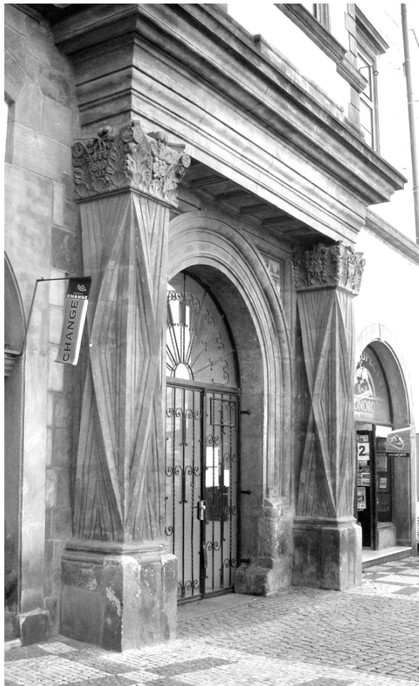
Рис. 5. Пилоны входа в здание, Прага, арх. Б. Рейт, XVI в.
