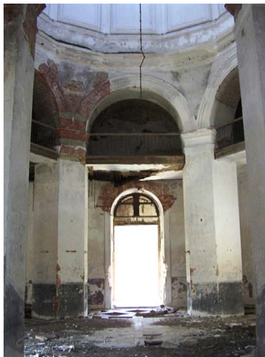
Рис. 5. Интерьер храма Воскресения Христова. Современное состояние
