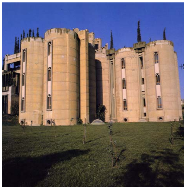
Рис. 8. Бофилл. «Фабрика», Испания
