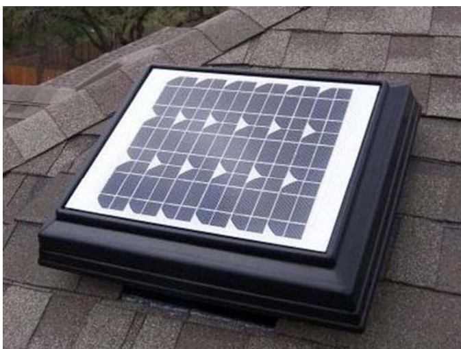
Рис. 2. Полностью автоматизированный мансардный вентилятор, снабженный солнечной батареей
