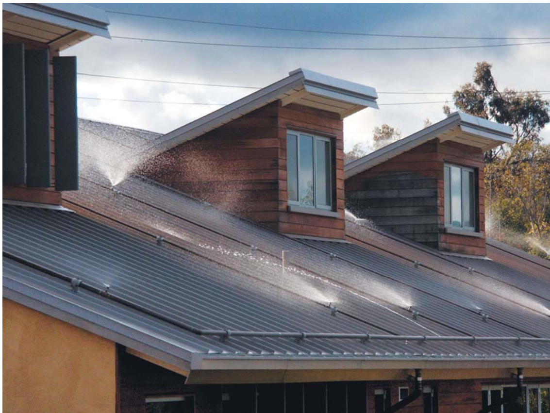
Рис. 7. Пример автоматизированной системы полива для охлаждения нагретых поверхностей
