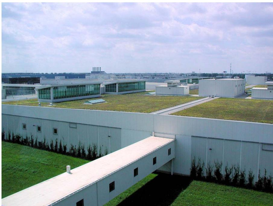
Рис. 9. Зеленая кровля цеха окончательной сборки завода Форд в Ривер Руж
