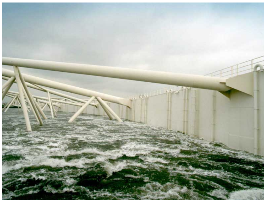
Рис. 12. Барьер Maeslantkering в плавучем состоянии
