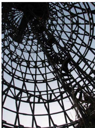
Рис.4. Водонапорная башня. Вид снизу на винтовую лестницу
