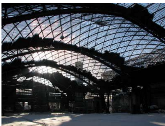
Рис.2. Листопрокатный цех. Общий вид
