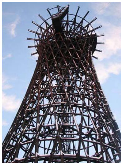
Рис.5. Водонапорная башня. Общий вид
