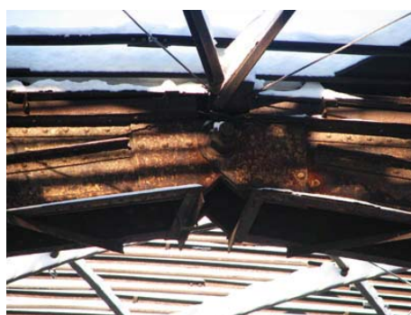
Рис.3. Листопрокатный цех. Шарнир соединения рамы пролёта
