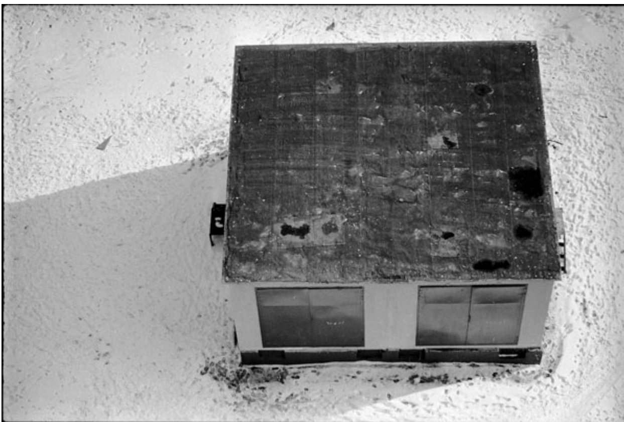
Рис. 2. Типовая трансформаторная будка во дворе жилого дома
