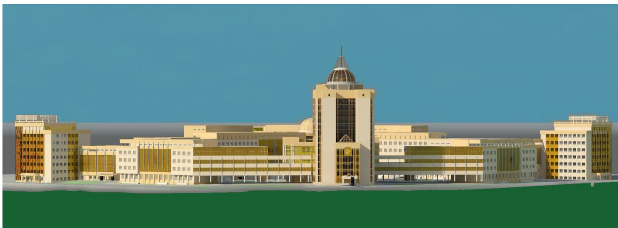
Рис. 12. ГУК НГУ – общий вид со стороны главного входа
