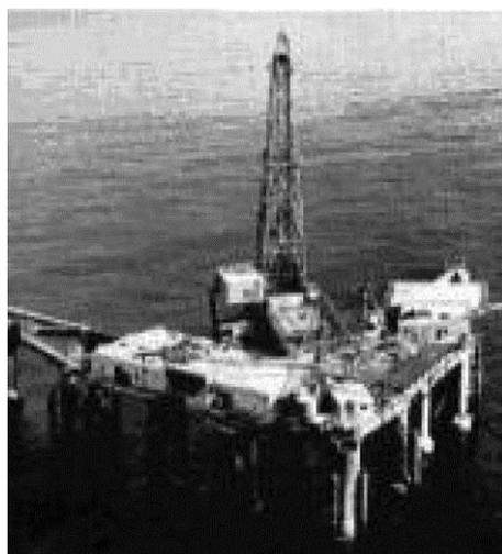
Рис. 6. Самоподъемная буровая установка «Mr. Gus», США, 1954 год
